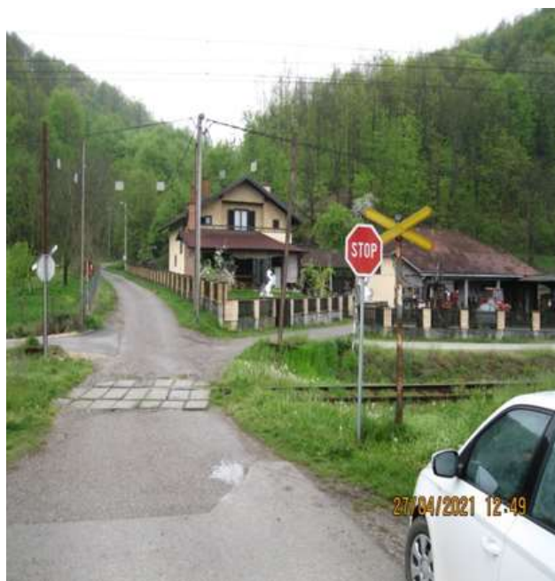
Slika 1 - Trougao preglednosti nije prisutan (Modriča 47+961 Brvno Vesići)
