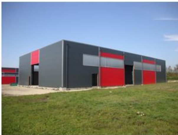
Slike PZ - PZ Termoelektrana Stanari, 17.10.2019. godine
